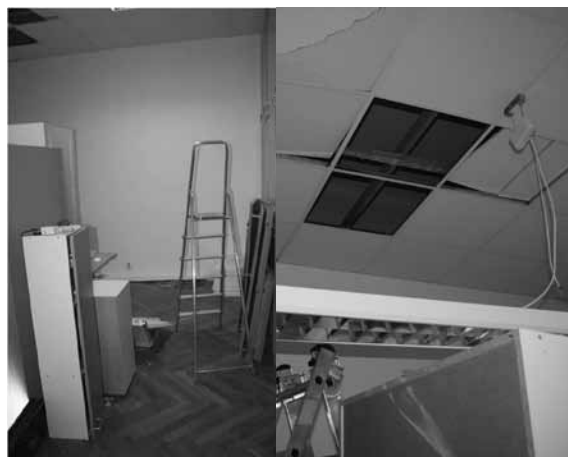
Slika 1. Mjesto događaja pri montaži svjetiljke na spušteni strop
