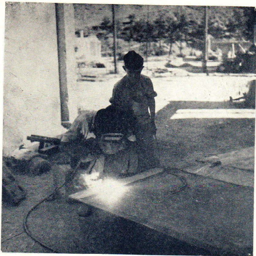
Slika 2. Električno lučno svarivanje. Svarivač ima zaštitnu kacigu i rukavice Pomoćni radnik nema zaštite na očima
