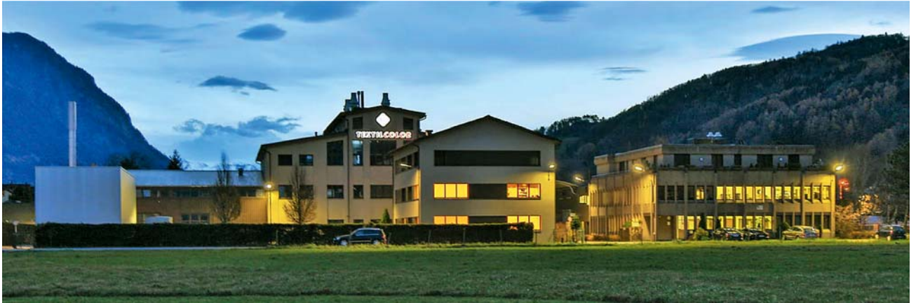
Sl.2 Upravna zgrada i pogoni tvrtke Textilcolor AG u Sevelenu, Švicarska
