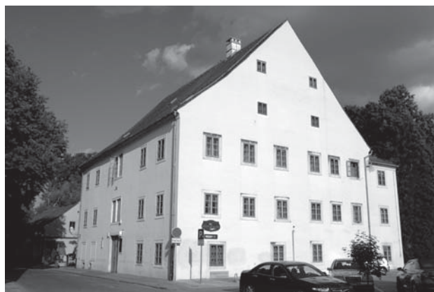
6. Pogled na zgradu sa sjeverozapada / Northwest view of the building
