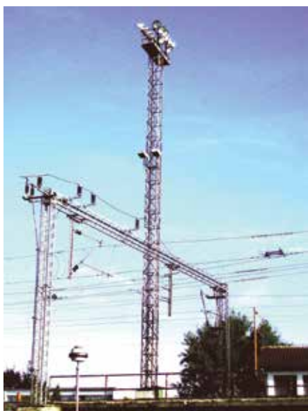
Slika 1. Rešetkasti reflektorski stup
