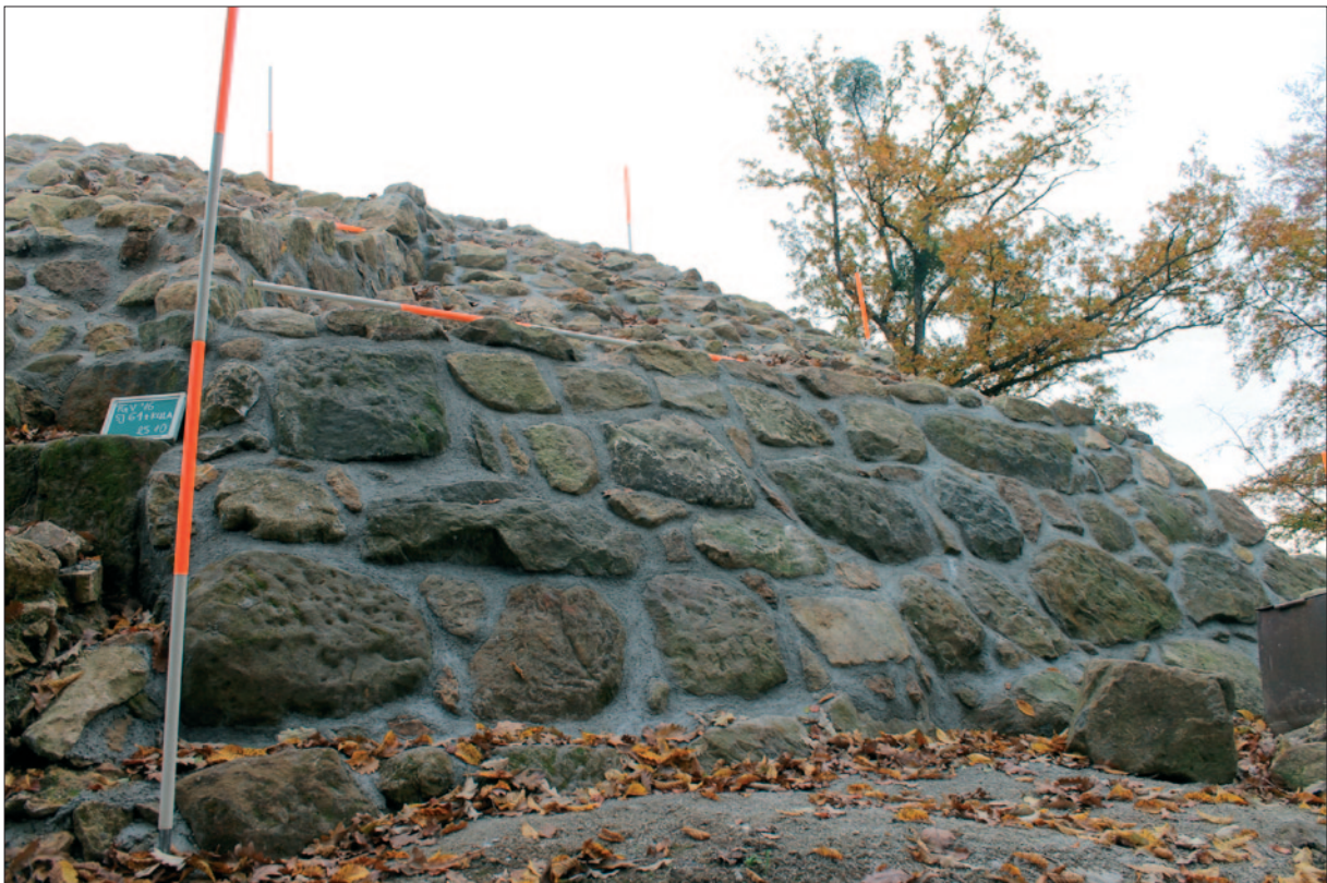
Sl. 3 Pogled sa zapada na konzervirani zapadni dio branič kule (snimila: T. Tkalčec)
