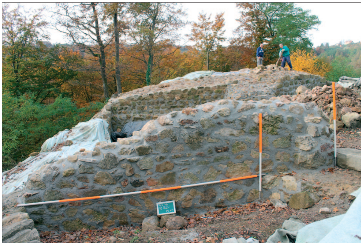
Sl. 4 Pogled na sjeverno lice zida SJ 52 nakon konzervatorskih radova (snimila: T. Tkalčec)
