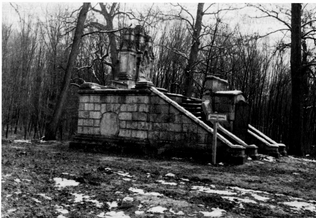
Grobnica Jelačić neposredno prije početka obnove
