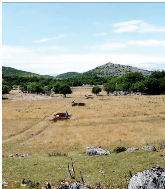
Sl. 8. Iskapanje probnih sondi na plinovodnoj trasi kod zaselka Čorluk (foto: Š. Vrkić, 2010.).
