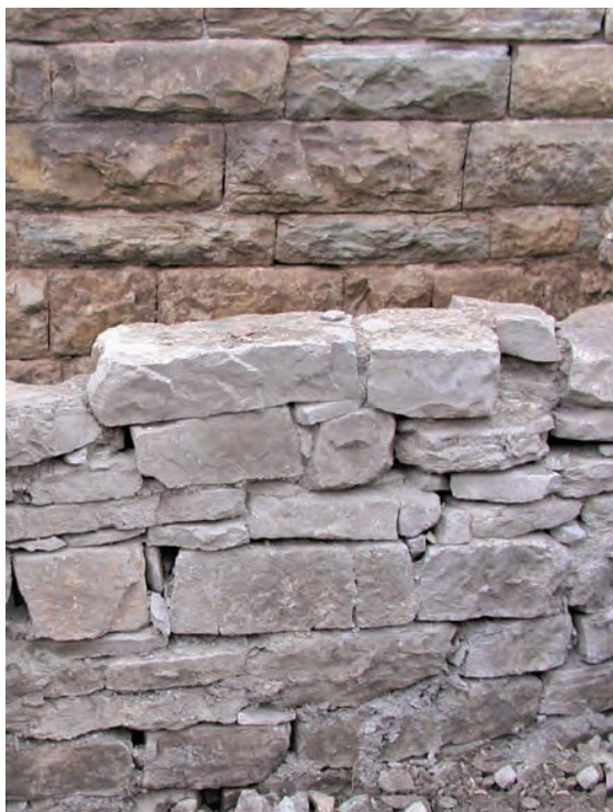
Sl. 66. Željeznodobni bedem – segment vanjskog lica u trenutku otkrića
