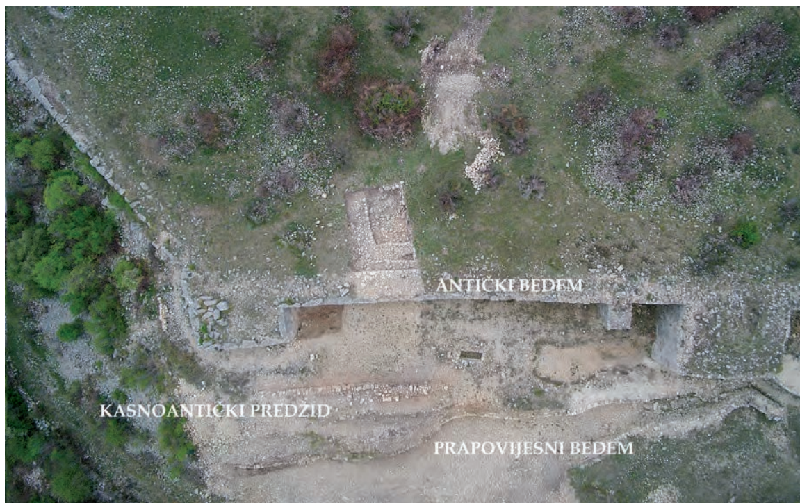
Sl. 28. Istraženi dijelovi prapovijesnih, antičkih i kasnoantičkih fortifikacija na sjevernoj strani gradinskog uzvišenja Fig. 28. Explored parts of prehistoric, antique and late antique fortifications on northern side of hill-fort's high ground (zračni snimak 2017., foto /2017 aerial photo by: M. Gospić)
