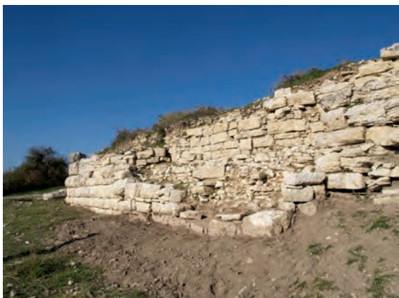
Sl. 49. Pogled na vanjsko lice željeznodobnog bedema unutar strukture antičkih zidina
