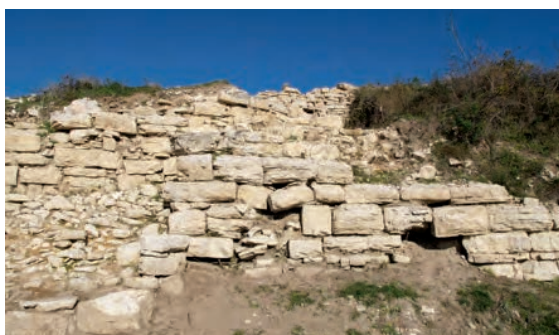
Sl. 47. Vanjsko lice antičkog bedema s presloženim rustičnim bunjama; POZICIJA 2
