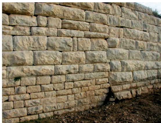
Sl. 14. Zapadna strana antičkih fortifikacija – segment vanjskog zidnog plašta
