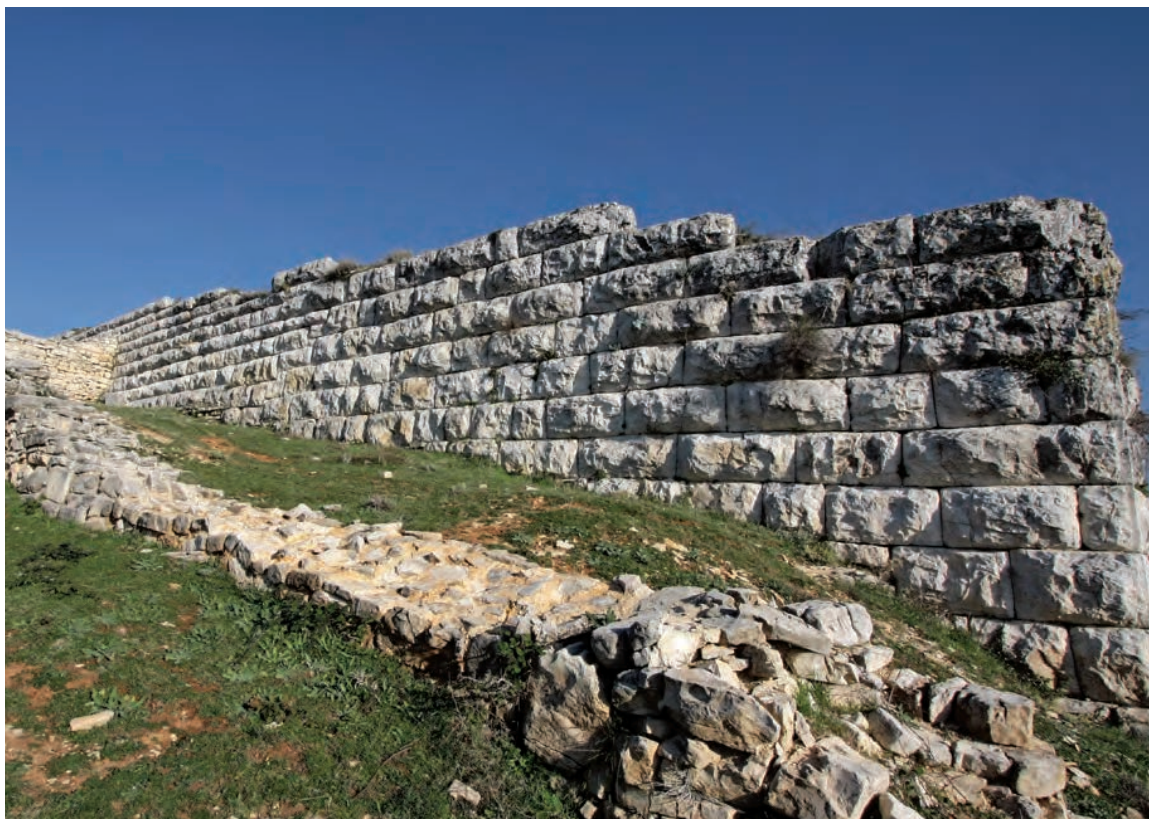
Sl. 11. Zapadna strana antičkih i kasnoantičkih fortifikacija – pogled na masivne rustične bunje kod glavnog gradskog ulaza
