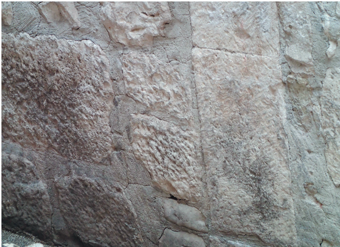
SLIKA 2. Blokovi pri temeljima kuće Bosanska 10 u Splitu (foto: N. Cambi)
