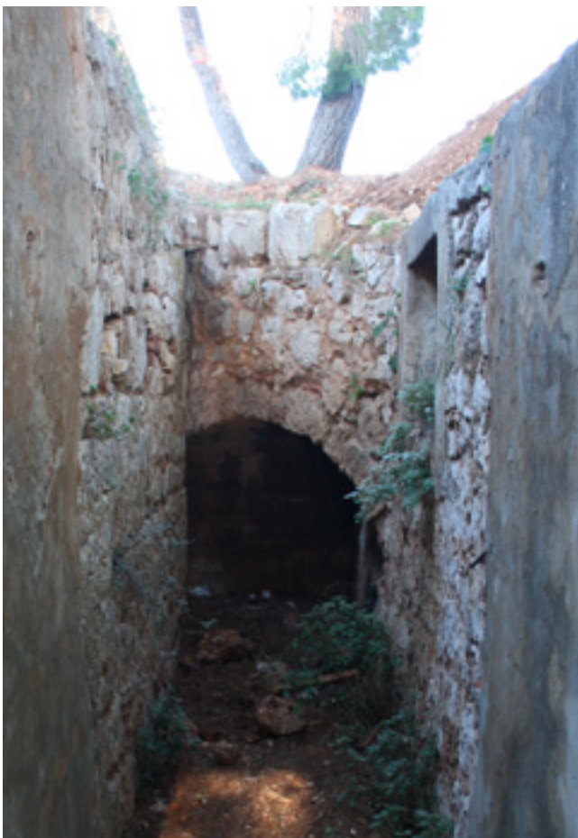
23. Pogled na kontrafor kojim je ojačana barutana na tvrđavi sv. Ivana (foto: I. Glavaš) Buttress supporting the gunpowder magazine in St John's fort
