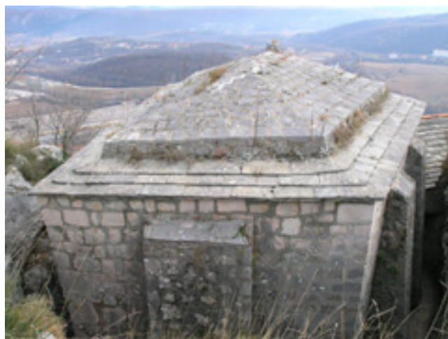
4. Pogled odozgo na mletačku barutanu na kninskoj tvrđavi (foto: I. Glavaš)
