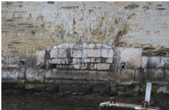
8. Zazidani topovski otvor do barutane na tvrđavi sv. Nikole (foto: I. Glavaš)
