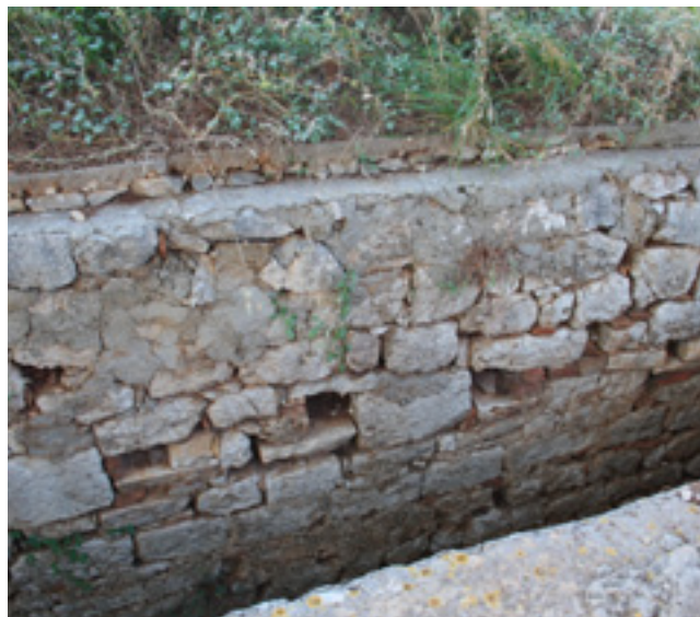
22. Pozicija odušaka za zrak na barutani na tvrđavi sv. Ivana (foto: I. Glavaš) Position of air vents at the gunpowder magazine in St John's fort
