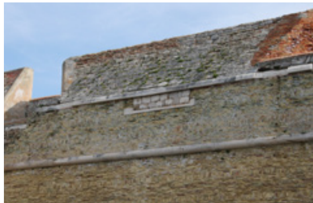
9. Detalj zazidanog topovskog otvora na jugozapadnoj kurtini tvrđave sv. Nikole (foto: I. Glavaš)
