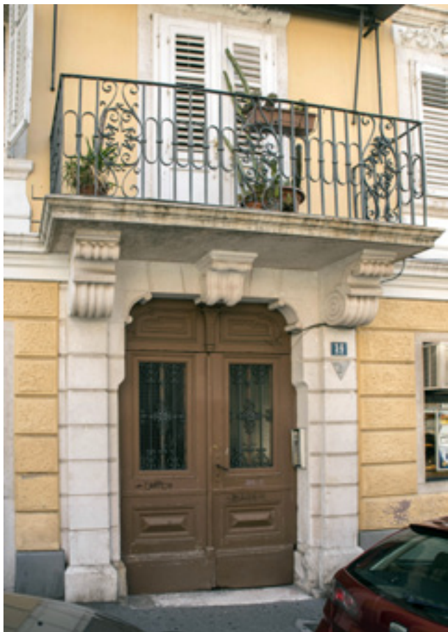
8. Glavni portal s balkonom ostatak je izvornog pročelja iz 18. stoljeća (foto: N. Vasić, 2017.)
