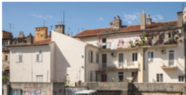
9. Začelje palače na kojemu su danas vidljive brojne dogradnje te zidni istak koji predstavlja trag porušenog zapadnog krila (foto: N. Vasić, 2017.)
