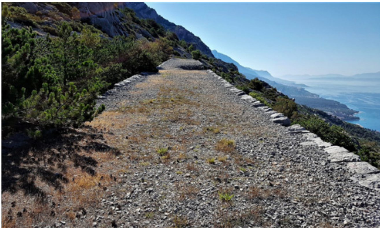
11. Postroj ceste je građen od krupnog kamena i s dvostrukim slojem šljunka različite gradacije, te s utabanim nasipom sitnije granulacije na samom kolniku
