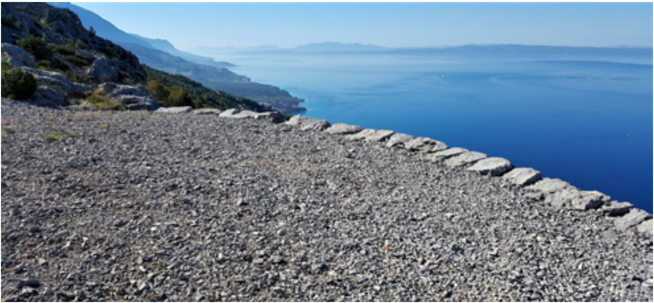
12. Rubnjaci ceste su od masivnog kamenja priklesanog na gornjoj plohi Curbstones are made of massive rocks attached to the surface by masonry
