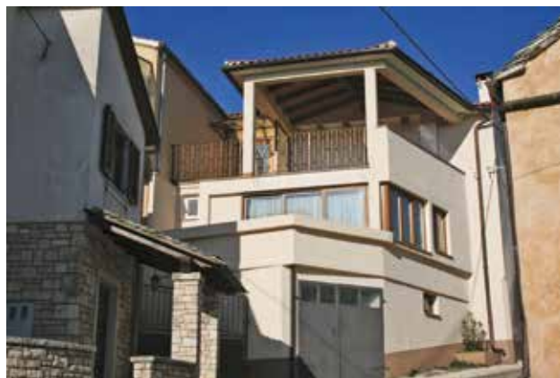
20 Isti sklop nakon „obnove“ (foto: B. Nefat, 2016.) The same complex after »reconstruction« (photo: B. Nefat, 2016)
