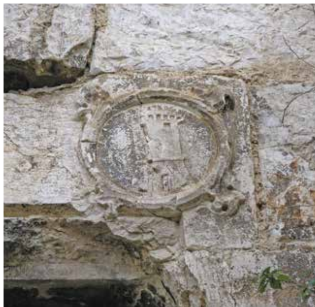
2 Grb na desnoj strani nadvratnika ulaznih vrata u Čorićev toranj (foto: I. Glavaš)
