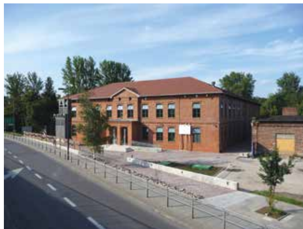
11 Barrack building of the former supply complex of the Krakow Fortress, adaptation for the Home Army Museum (photo: W. Rymśza-Mazur, 2011). Zgrada vojarnje nekadašnjega aprovizacijskog kompleksa tvrđave Krakow, adaptacija na Muzej Zemaljske armije (foto: W. Rymśza-Mazur, 2011.).
