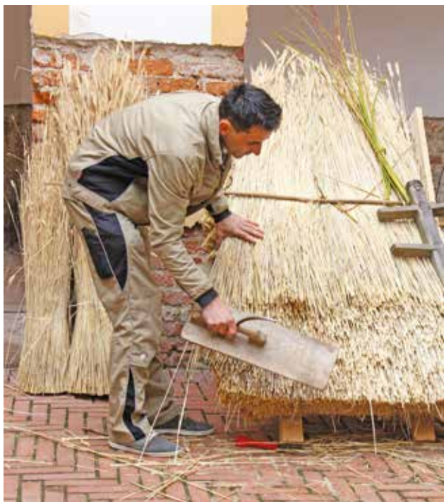
2 Polaganje snopića slame na krovnu konstrukciju. Majstor Janez Golnar pričvršćuje ih vrbovim prućem i poravnava s donjim rubom daske. (foto: G. Jerabek)
