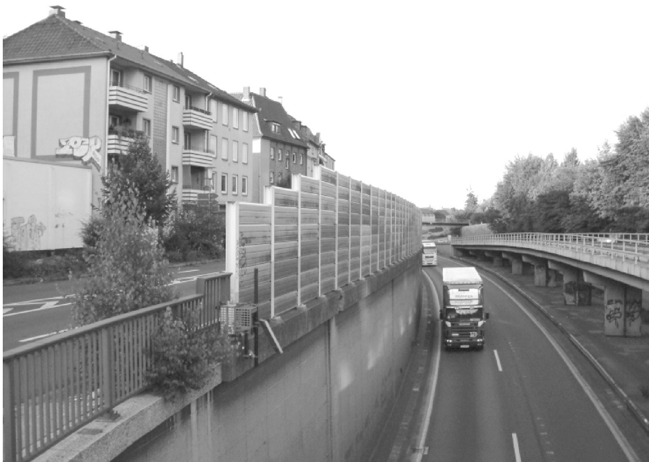
Slika 3. Barijere za zaštitu od buke uz cestovnu prometnicu
