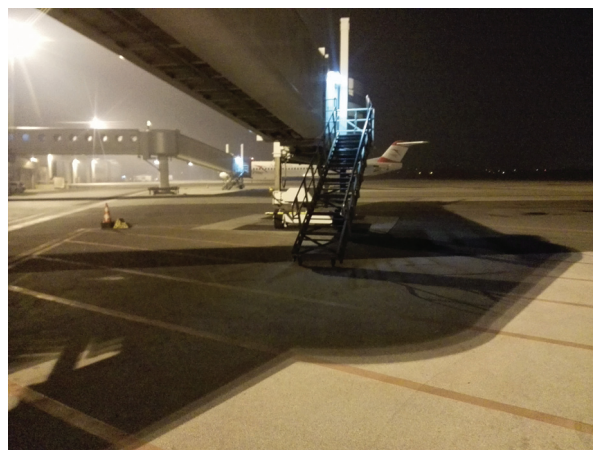
Slika 5 Rasvjeta platforme sa sjenama na pozicijama s aviomostovima Međunarodnog aerodroma "Sarajevo"
