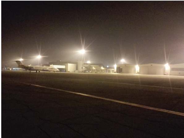
Slika 1 Rasvjeta platforme međunarodnog aerodroma "Sarajevo"
