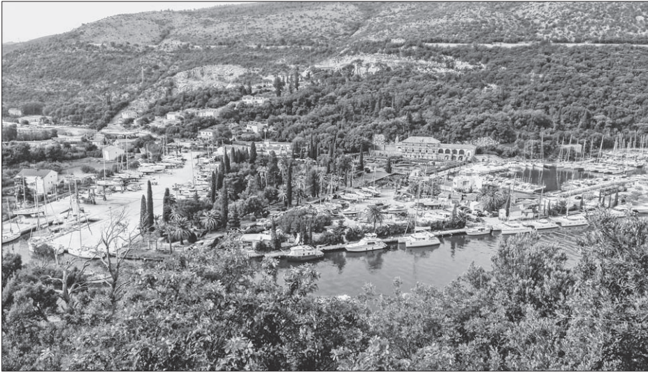
SL. 2. LADANJSKI KRAJOLIK NARUŠEN NEOBZIRNOM NOVOM IZGRADNJOM, LIJETNIKOVAC JUNIJE LUKOV SORGO FIG. 2 RURAL LANDSCAPE DEGRADED BY INCONSIDERATE NEW CONSTRUCTION, VILLA JUNIJE LUKOV SORGO
