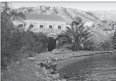
SL. 14. LJETNIKOVAC ZAMAGNA, JEDAN OD DVA U RIJEKI DUBROVAČKOJ S IZVORNIM PRISTUPOM VODI FIG. 14 VILLA ZAMAGNA, ONE OF THE TWO IN RIJEKA DUBROVAČKA WITH ORIGINAL ACCESS TO WATER
