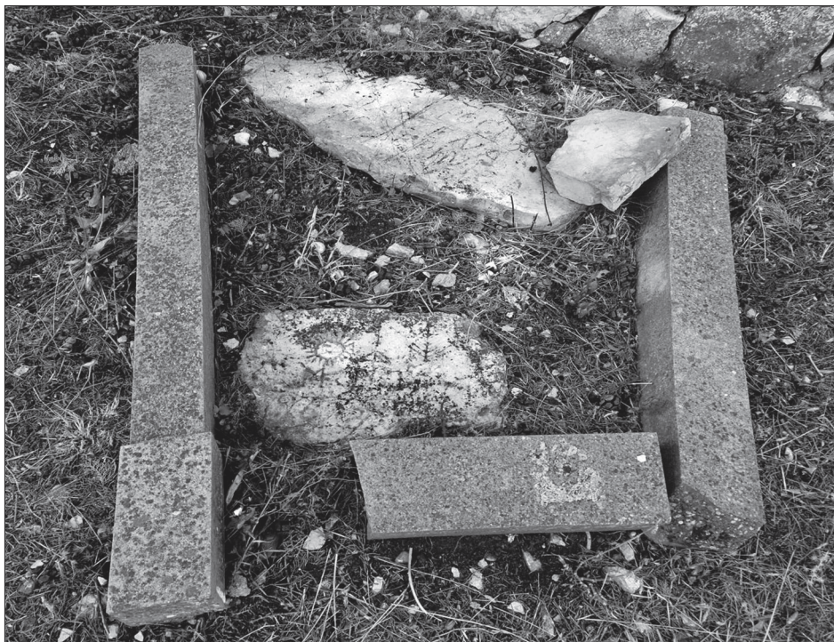
Sl. 10. Oštećena grobna ploča 1 u lunskom groblju, foto: M. Brajša, 2014.
