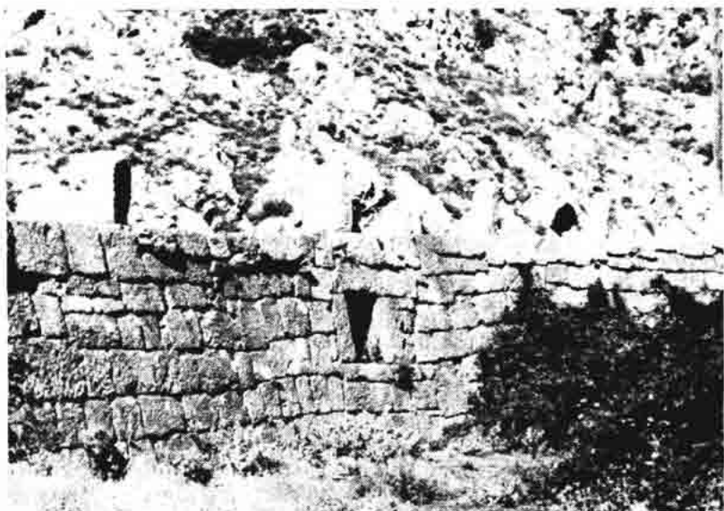
Sl. 69. — Podzid Kneževićeve Jozefinske ceste s propustom pred Senjom, 1959. godine.
