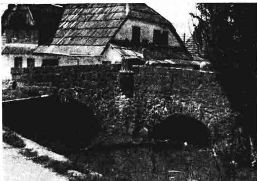
Sl. 61. Struppijev most preko potoka Radetića u Brinju sa sunčanom urom na mostu. Snimio ing. S. Nossan, 1957.
