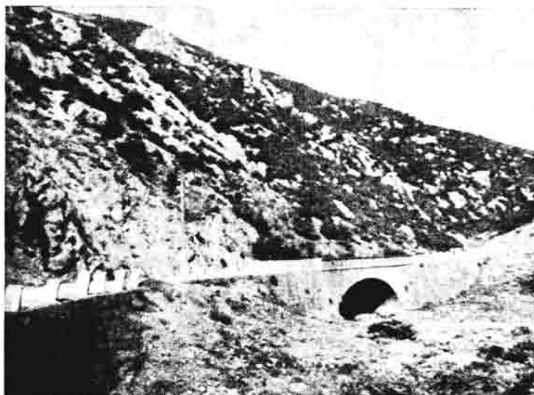
Sl. 66. — Veliki most Kneževićeve Jozefinske ceste na izlazu Senjske drage. Snimio ing. S. Nossan, 1937.
