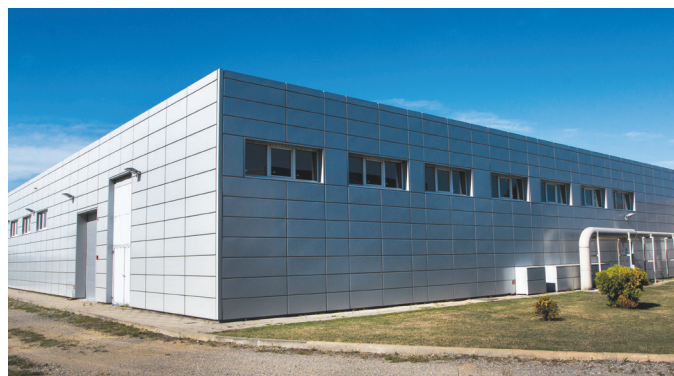
Slika 22: Novi pogon za preradu pitke vode na crpilištu Bikana u Virovitici
