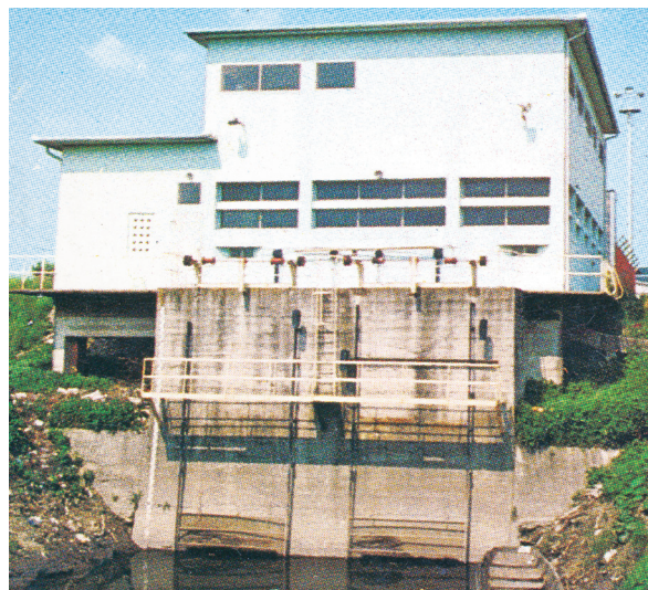
Slika 10: Crpna stanica na Savi u sklopu TE-TO Zagreb
