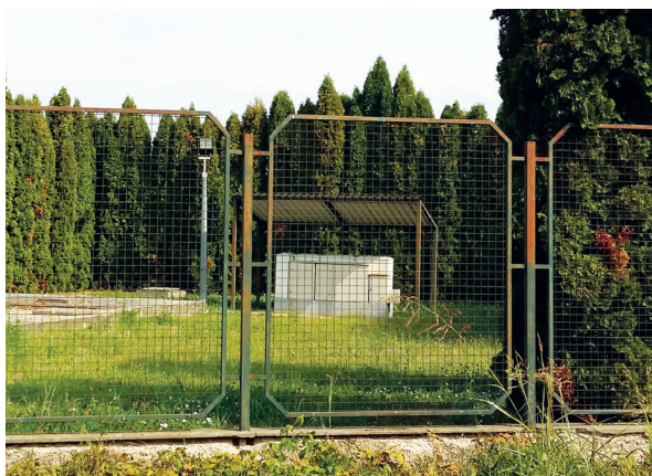
Slika 18: Crpna stanica Remetinec u Novom Zagrebu
