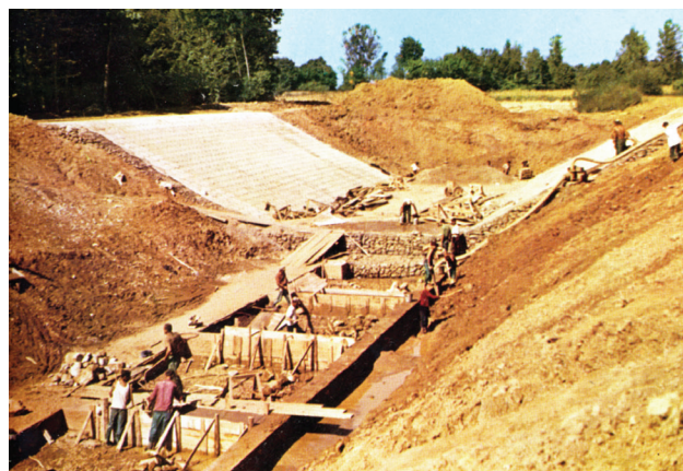
Slika 11: Radovi na regulaciji jednog vodotoka
