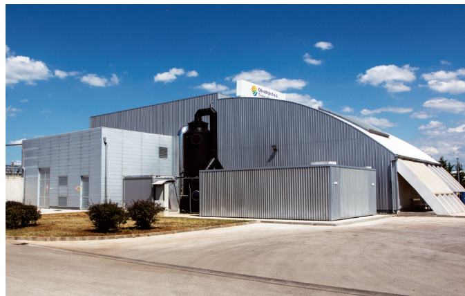
Slika 26: Uređaj za pročišćavanje otpadnih voda Centar u Zadru
