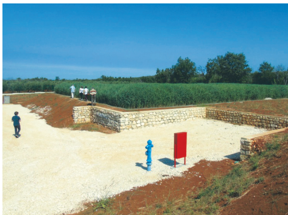
Slika 28: Polje za poliranje u sklopu biljnog uređaja za pročišćavanje otpadnih voda Kaštelir
