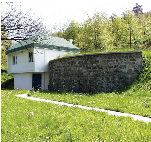
Slika 24: Vodospremnik Sv. Vid u sklopu vodoopskrbnog sustava Požeštine
