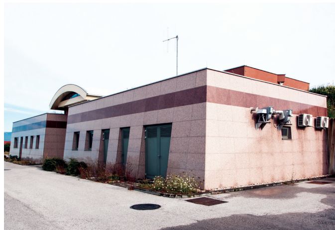
Slika 16: Novi vodospremnik Cerje u zagrebačkoj gradskoj četvrti Sesvete
