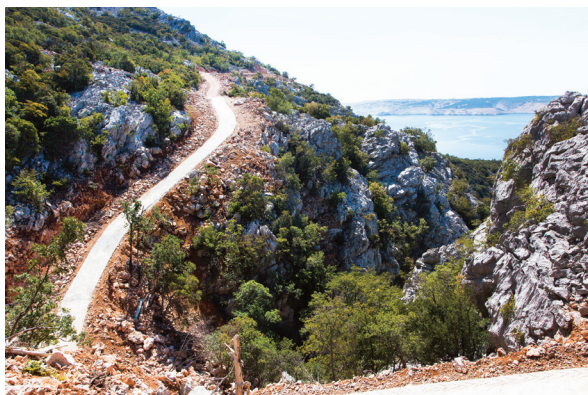
Slika 14: Detalj zamjenske trase vodovoda na dionici Stinice – Koromačina u velebitskim vrletima
