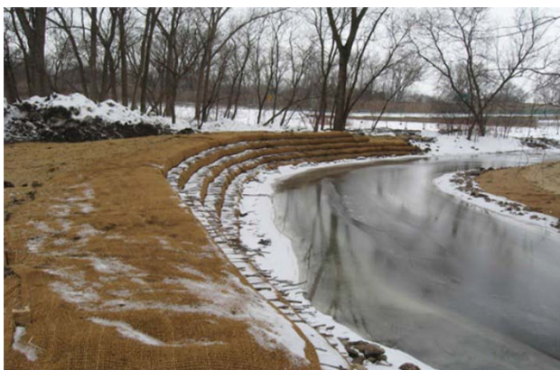
Slika 4. Metoda vegetated geogrids (vegeacijske geomreže) (Iowa Department of Natural Resources 2006)
