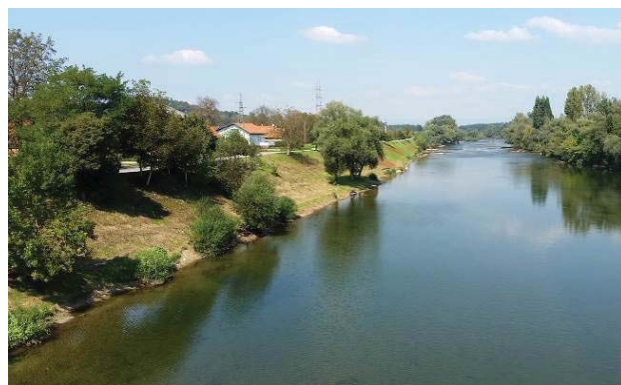
Slika 12. Obaloutvrda u mjestu Brodarci (Geokon-Zagreb d.d.)
