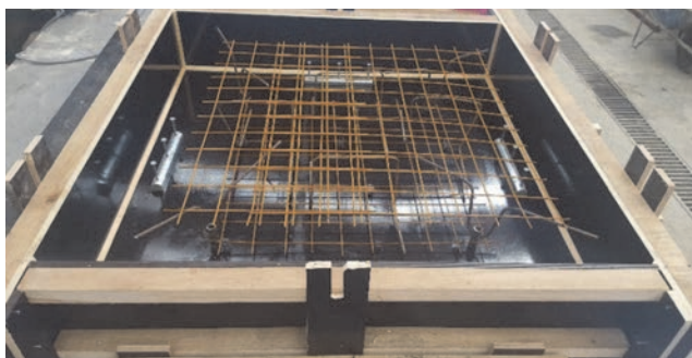
Slika 3. Prikaz armature ispitnog uzorka betonske ploče
