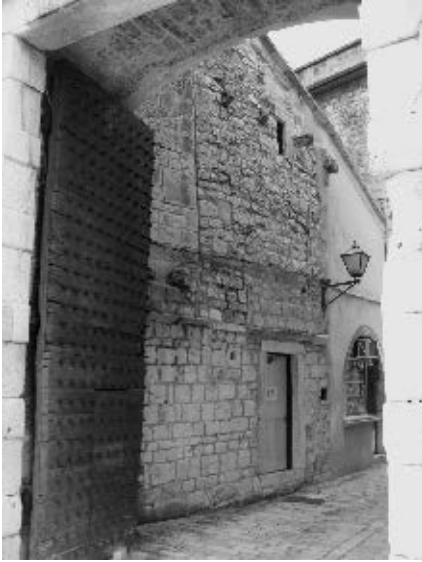
Krunište ogradnog zida u začelju kule sv. Nikole
