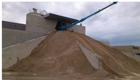
Slika 2.1 Fotografija betonare G.P.P. MIKIĆ, Omišalj, otok Krk
