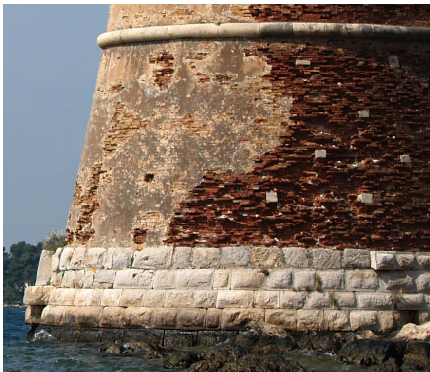
Sl. 8. Kameni blokovi isklesani u tehnicu bugnato rustico u podnožju tvrđave sv. Nikole u Šibeniku, sagrađene oko 1545. g. pred ulazom u kanal sv. Ante (foto: Ž. Krnčević)
