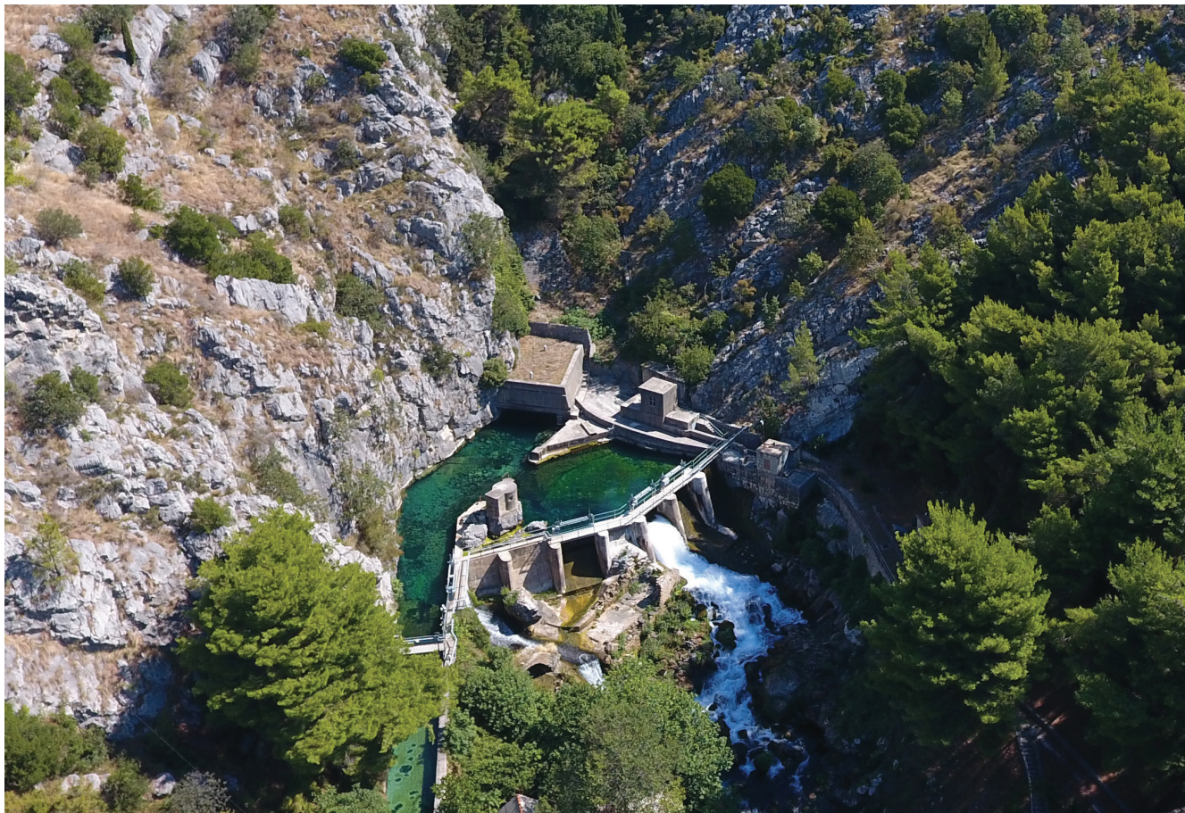
Sl. 1. Zahvatne građevine na izvoru rijeke Jadro (foto: M. Žabčić) Fig. 1. The water intake structures at the Jadro River's spring (photo: M. Žabčić)
