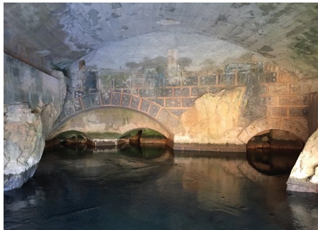
Sl. 7. Potporni zid s kraja XIX. stoljeća iznad izvora Jadra unutar zaštitne građevine iz 1946. (foto: N. Cingeli)
