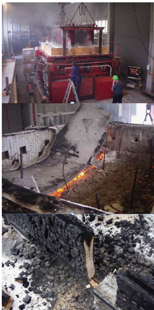
Slika 6 Gore: požarni test na stropnim panelima u tijeku; sredina: urušavanje nakon 75 minuta; dolje: poprečni presjek nosača izloženog požaru sa slojem drvenog ugljena[5]
