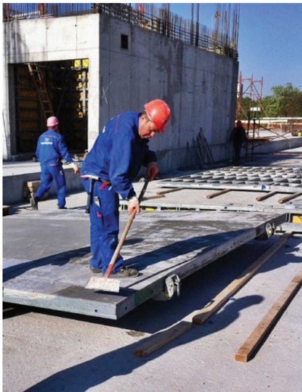
Slika 12 Čišćenje oplatne plohe
