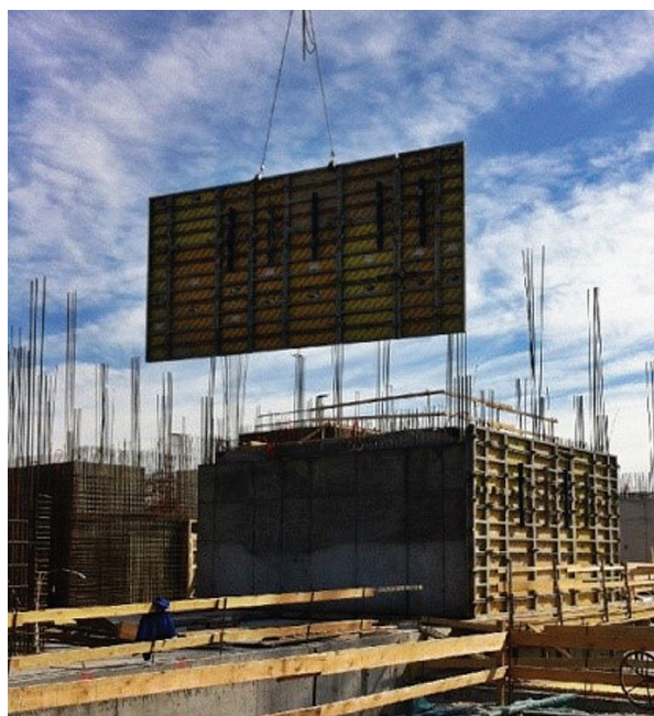
Slika 11 Skidanje oplata
