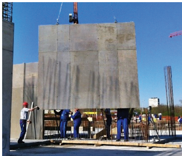
Slika 10 Postavljanje oplatnog sklopa
