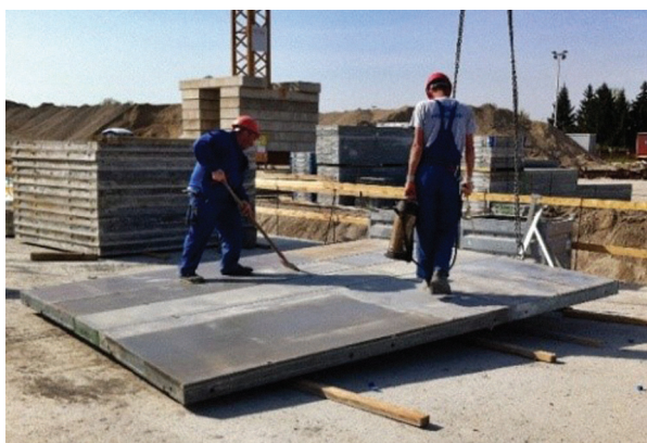
Slika 9 Priprema oplatnih ploha
