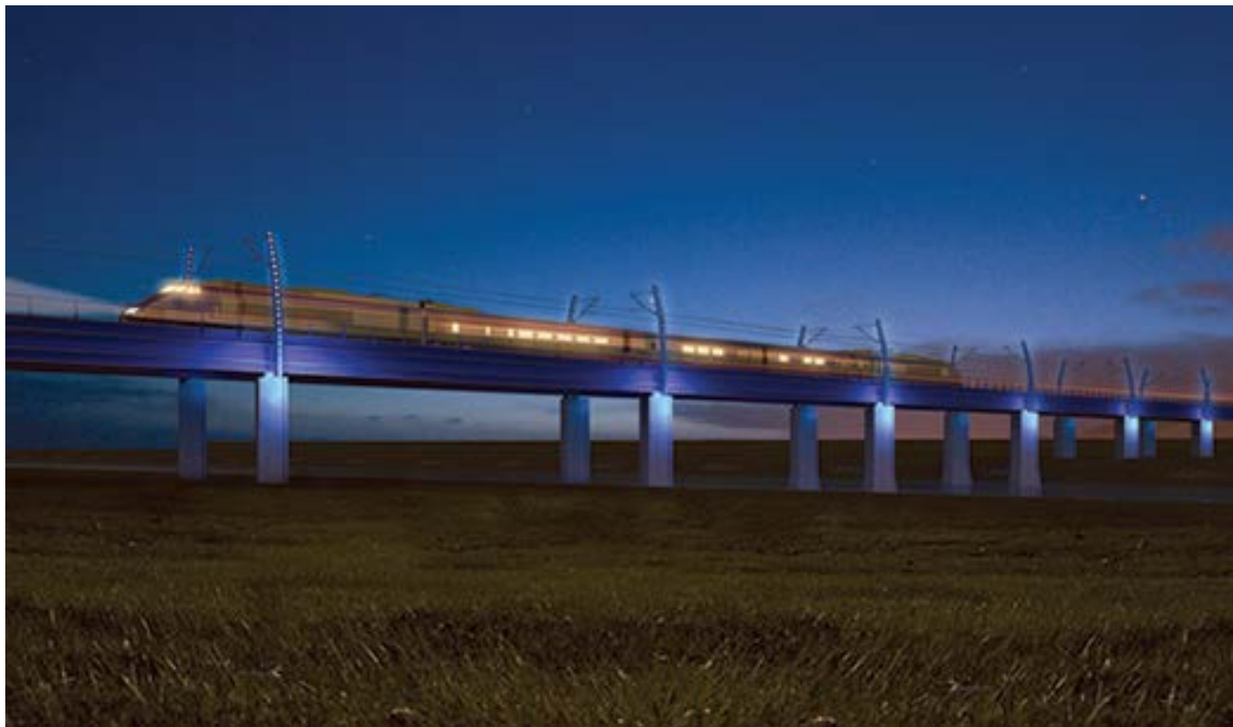
Slika 19. Budući željeznički most Podsused noću
