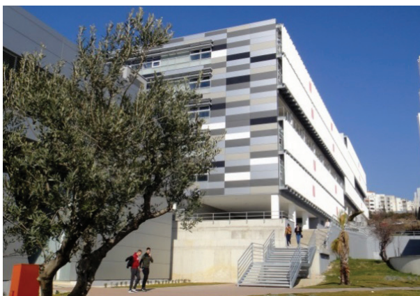
Slika 1 – Zgrada triju fakulteta: Kemijsko-tehnološki fakultet, Prirodoslovno-matematički fakultet i Pomorski fakultet u Ulici Ruđera Boškovića 35 u Splitu
