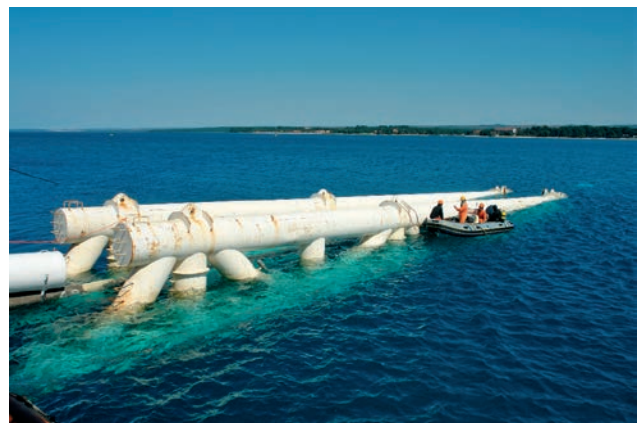
Slika 11. Polaganje podmorskog plinovoda
