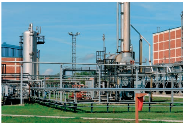
Slika 5. Podzemno skladište plina Okoli
