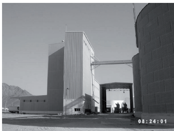
Slika 1 Postrojenja za pohranu i mljevenje pšenice nazivnog kapaciteta 120 t/24 sata u luci Fujairah u UAE
