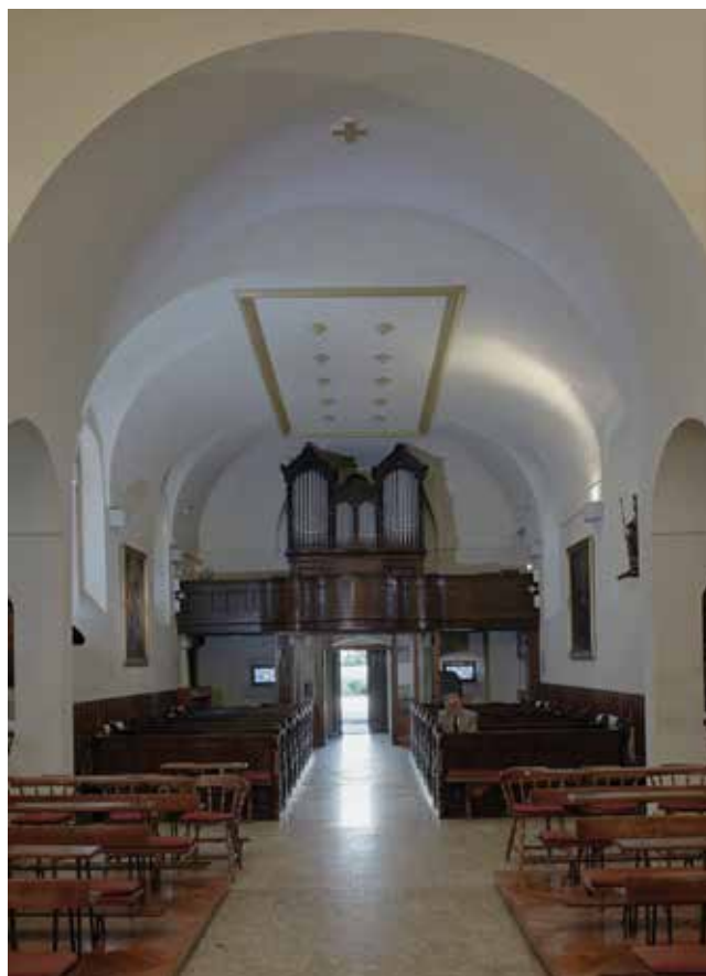
14. Unutrašnjost, pogled prema ulazu (foto: F. Vučemilović)
