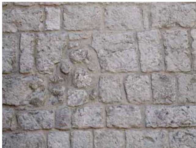
3. Ostatci izvornog okvira romaničkog prozorskog otvora (foto: M. Braun)
