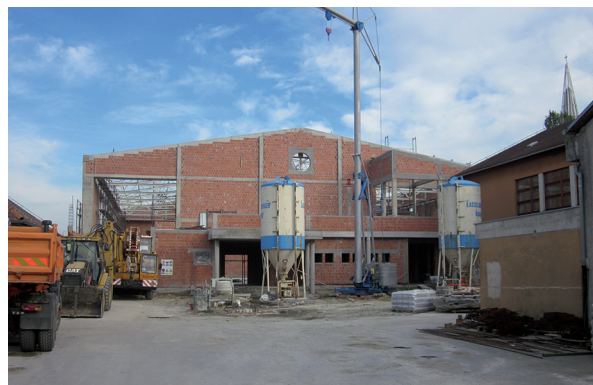
Slika 4. Sportska dvorana u Okučanima – građevina u gradnji, 2012. godina, "Program EIB 2"
