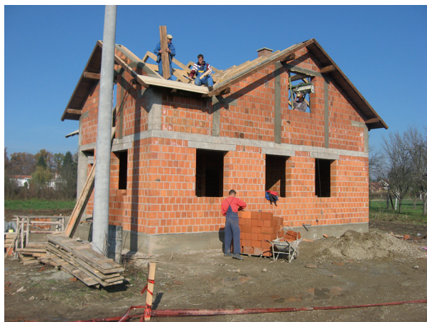
Slika 1 Izgradnja obiteljske kuće u Pakracu u sklopu “Programa organizirane obnove” – 2010. godina
