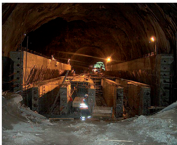
Slika 5: Izvedeni glavni i sekundarni uzdužni nosači.
