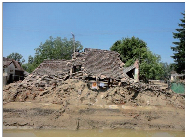
Slika 3. Srušena stambena zgrada, lipanj 2014. Izvor: Ministarstvo graditeljstva i prostornoga uređenja
