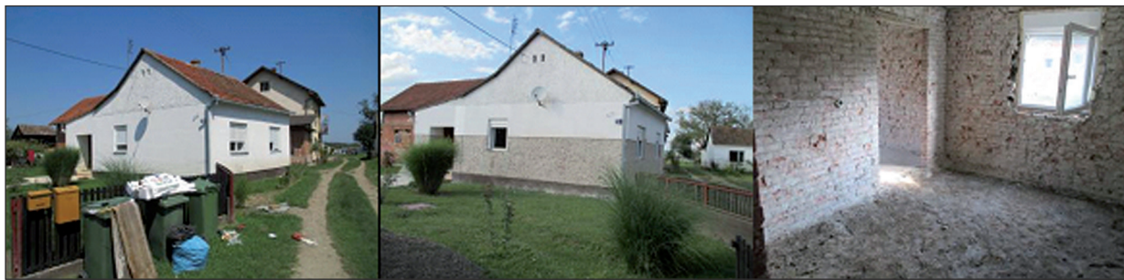
Slika 6. Izvođenje radova, izvana i iznutra, Bana Josipa Jelačića 35., Gunja, kolovoz 2014., Izvor: Agencija za pravni promet i posredovanje nekretninama
