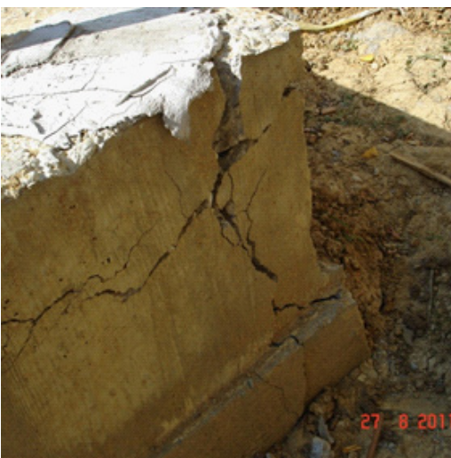
Slika 10. Drobljenje AB naglavne grede. [7]
