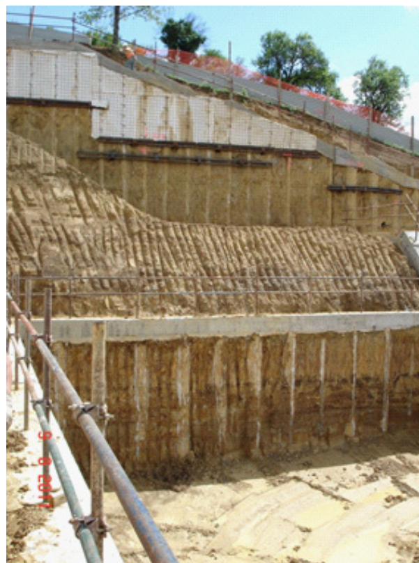
Slika 7. Iskop i zaštitna konstrukcija početkom kolovoza 2011. [7]
