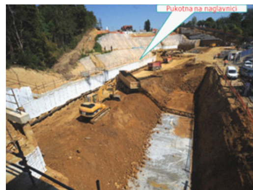
Slika 13. Hitna mjera, zatrpavanje građevinske jame 26.08.2011 [7]
