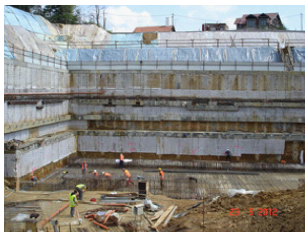
Slika 18. Zaštitna konstrukcija i izvedba temeljne ploče krajem svibnja 2012 [7]
