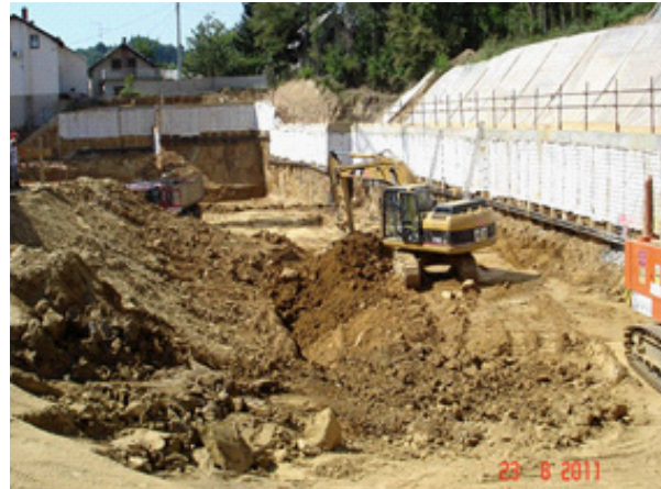
Slika 6. Iskop i zaštitna konstrukcija TIP-3 [7]
