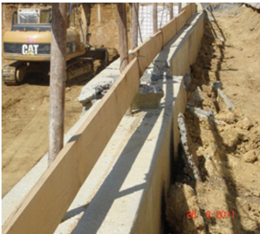
Slika 9. Drobljenje naglavne grede 25.08.2011. [7]
