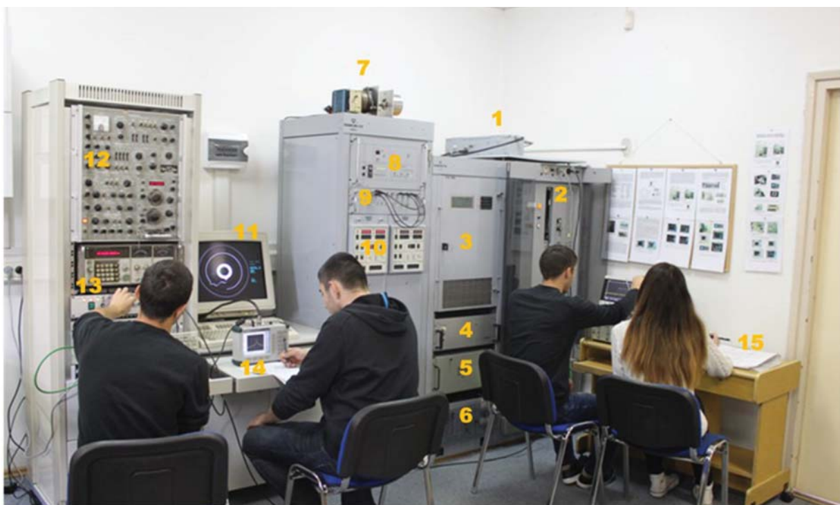
1. RF pojačalo s STC (PSR-Primary Surveillance Radar); 2. Podustav radarskog prijemnika (PSR); 3. Podustav za digitalnu obradu radarskih signala (PSR); 4. Podustav za obradu i prikaz radarskih podataka (koristi se za PSR i SSR - Secondary Surveillance Radar); 5. Podustav za ekstrakciju radarskih ciljeva (SSR); 6. Test mjerna jedinica (PSR); 7. Simulator vrtnje radarskih antena s enkoderom (PSR i SSR); 8. Podustav za prijem, obradu i distribuciju podataka o trenutnom položaju radarskih antena (PSR i SSR); 9. Mjerna i komutacijska ploča signala (PSR i SSR); 10. Primo-predajnici s digitalnom obradom radarskih signala odgovora od pitanog zrakoplova, broda (SSR); 11. Panoramski pokazivač za prikaz obrađenih radarskih podataka (PSR i SSR); 12. Simulator SSR - interogatora („pitač“ na radarskoj postaji) i transpondera („odgovarač“ na zrakoplovu, brodu..). 13. Novi podsustav radarskog simulatora odašiljača i dva cilja (SRO&2C); 14. Studenti iz predmeta Radarski sklopovi mjere na radarskom prijemniku PSR korištenjem SRO&2C; 15. Studenti mjere na odašiljaču sekundarnog radara.
