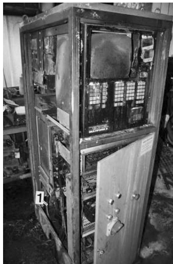
Slika 4: Požar na upravljačkoj jedinici radnog stroja (Papić, lit. 6.)
