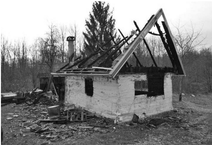
Slika 1: Požar individualnog stambenog objekta (drvene kuće) (Papić, lit. 9.)
