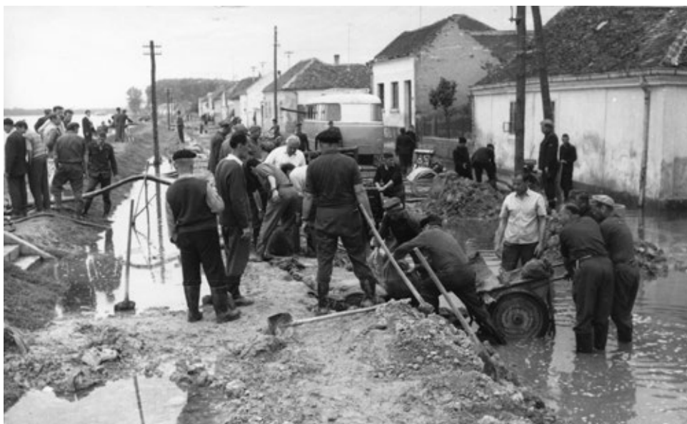
Slika 2. Radnici poduzeća »Kanalizacija« montiraju pumpe za izvlačenje fekalnih voda
