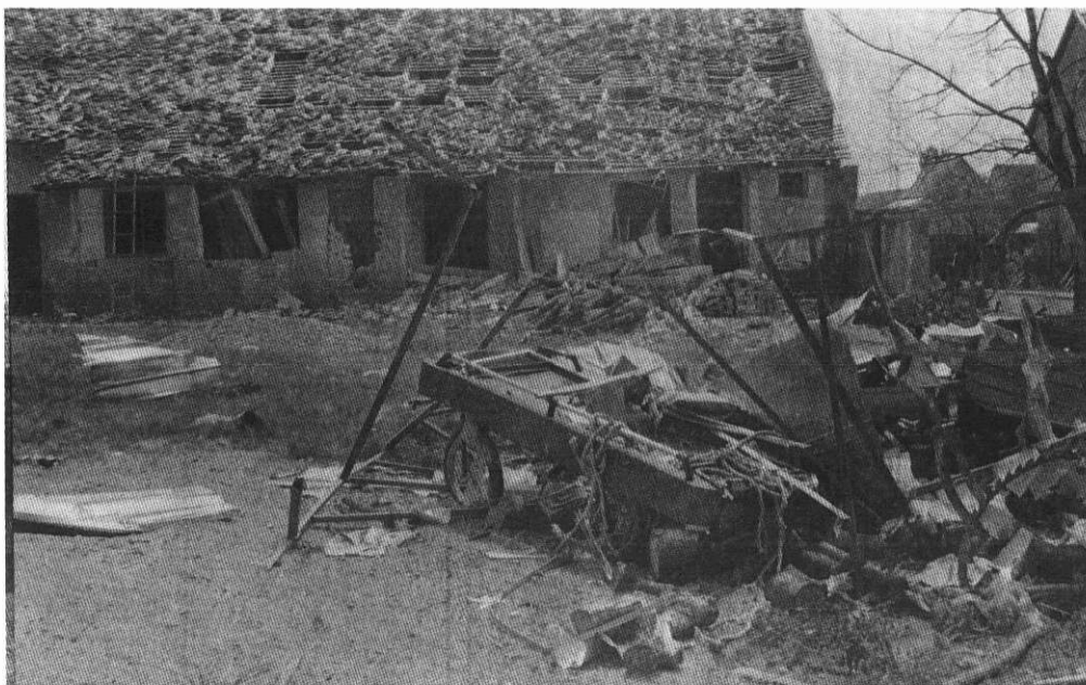
SLIKA 4. Vanjski izgled zgrade i dvorišta ambulante u Svilaju nakon avionskog napada FIGURE 4. The building and courtyard of the outpatient clinic in Svilaj after an air-raid
