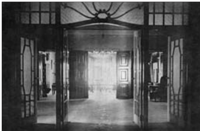
SL. 16. DETALJ GLAVNIH ULAZNIH VRATA DVORANE, POGLED PREMA FOYERU U STAROME DIJELU DOMA, FOTOGRAFIJA, 1922.
