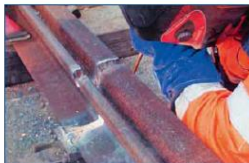
Slika 7. Zavarivanje nožice tračnice Figure 7. Welding of the rail foot
