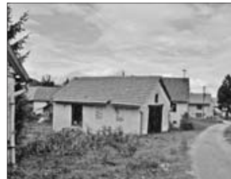
SL. 8. KUĆA MILANA GVOZDANOVICA IZ 1938. GODINE FIG. 8 MILAN GVOZDANOVIC'S HOUSE FROM 1938
