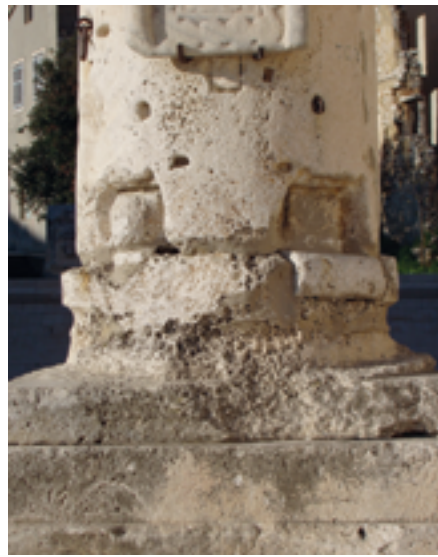
Slika 14. Baza rimske kolone s korijenima konzola pri dnu stupa – pogled s jugistočne strane
