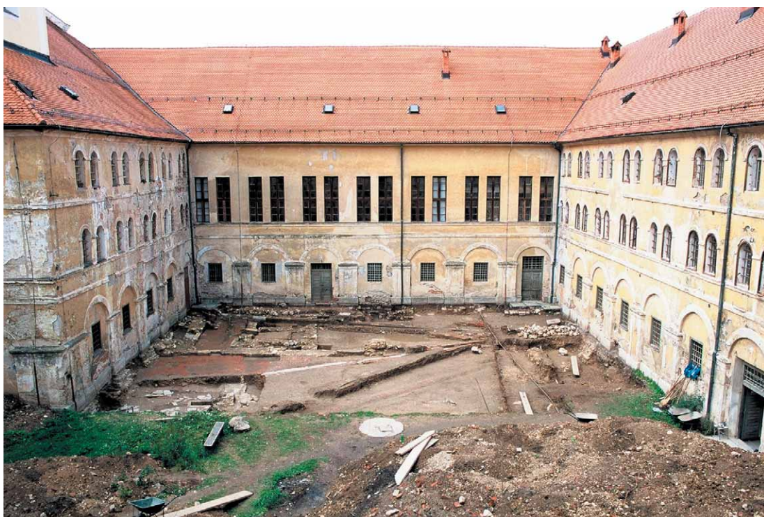
Slika 10. Pogled s istoka na sondu A nakon istraživanja (foto V. Barac)
