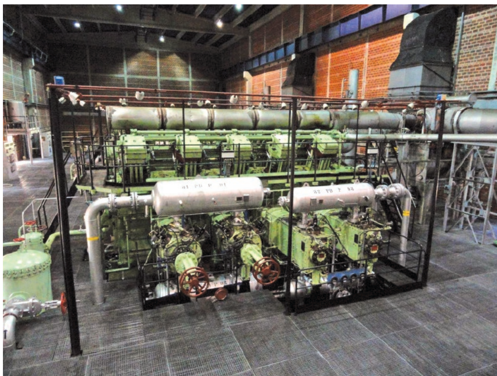
Slika 1. Postojeći kompresor KVR 410
