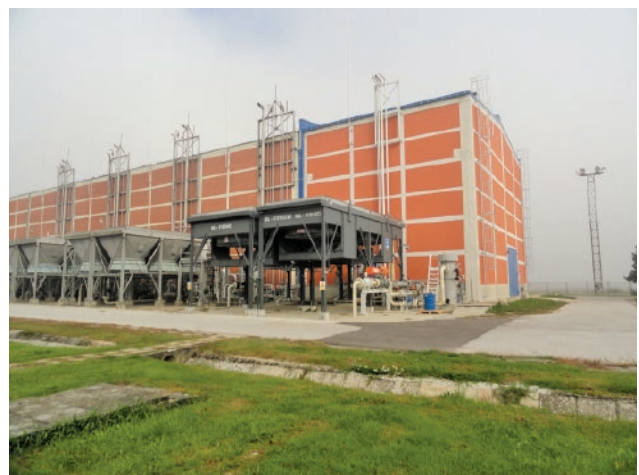
Slika 4. Dograđena kompresorska stanica
