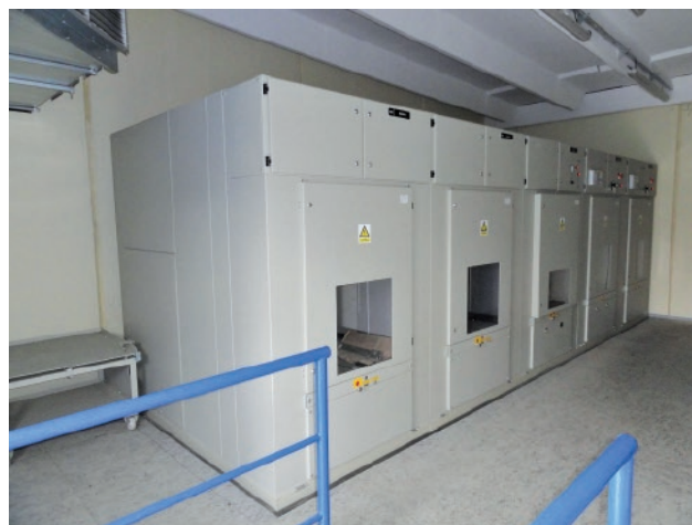
Slika 6. 35 kV postrojenje
